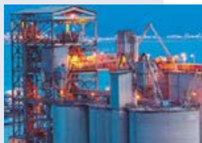
Cada reglamento exige unas determinadas actuaciones en el mantenimiento de las instalaciones.
